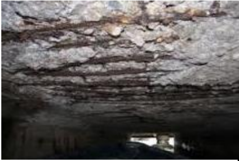
I.19. Interior del inmueble, Sótano 1
