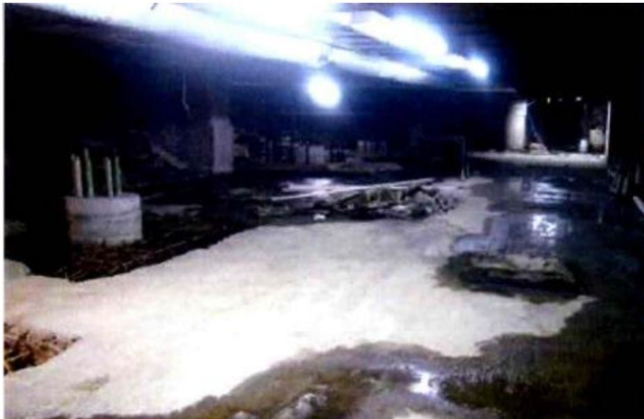
I.11. Interior del inmueble, Sótano 2
