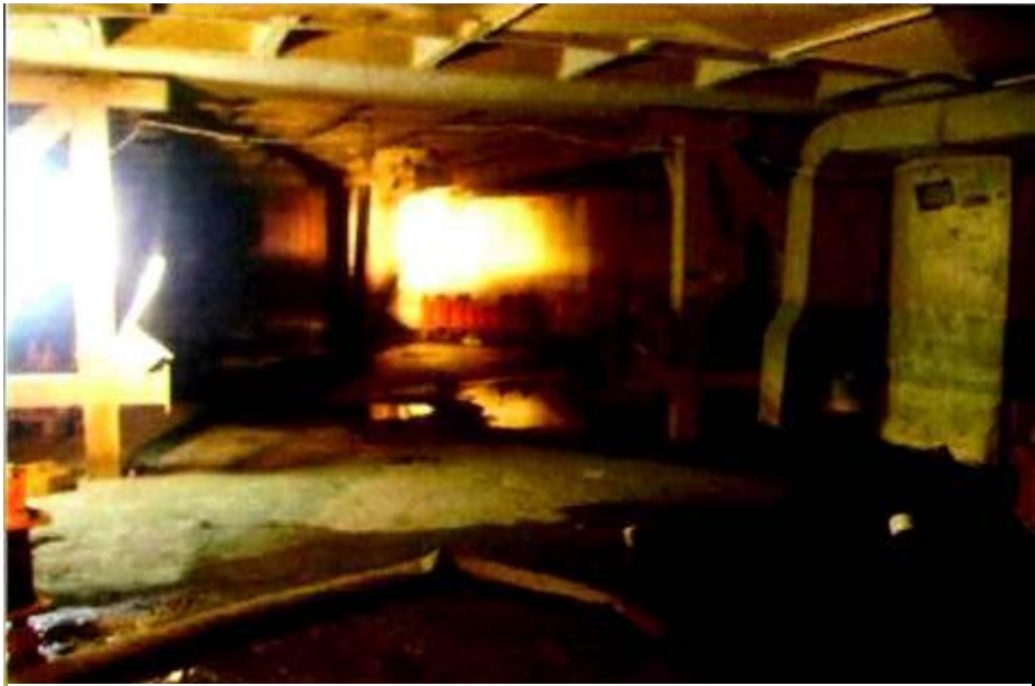
I.9. Interior del inmueble, Sótano 1
