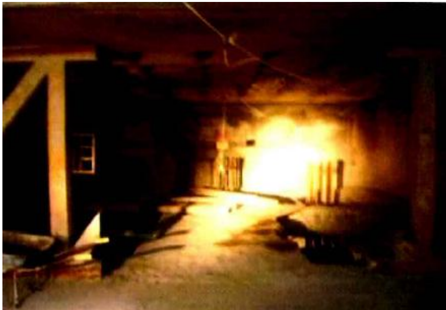
I.20. Interior del inmueble, Sótano 1
