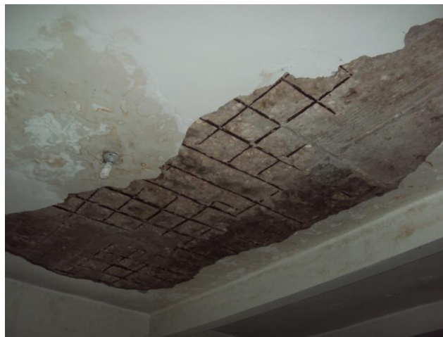
I.3. Interior del inmueble, Piso 3.
