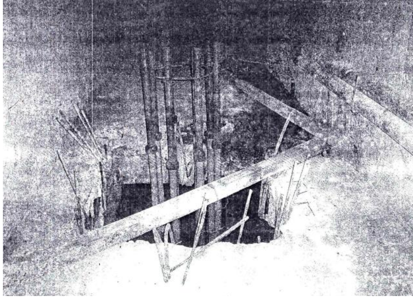
I.31. Interior del inmueble, Sótano 2.
