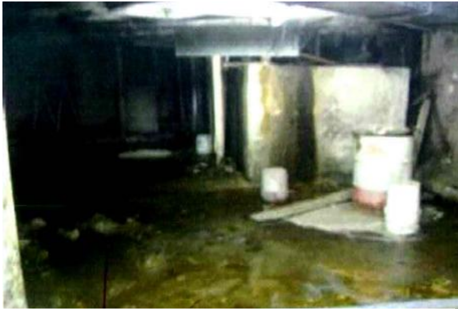
I.15. Interior del inmueble, Sótano 2
