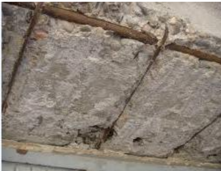
I.4. Interior del inmueble, Piso 4, Eje F 1-2.
