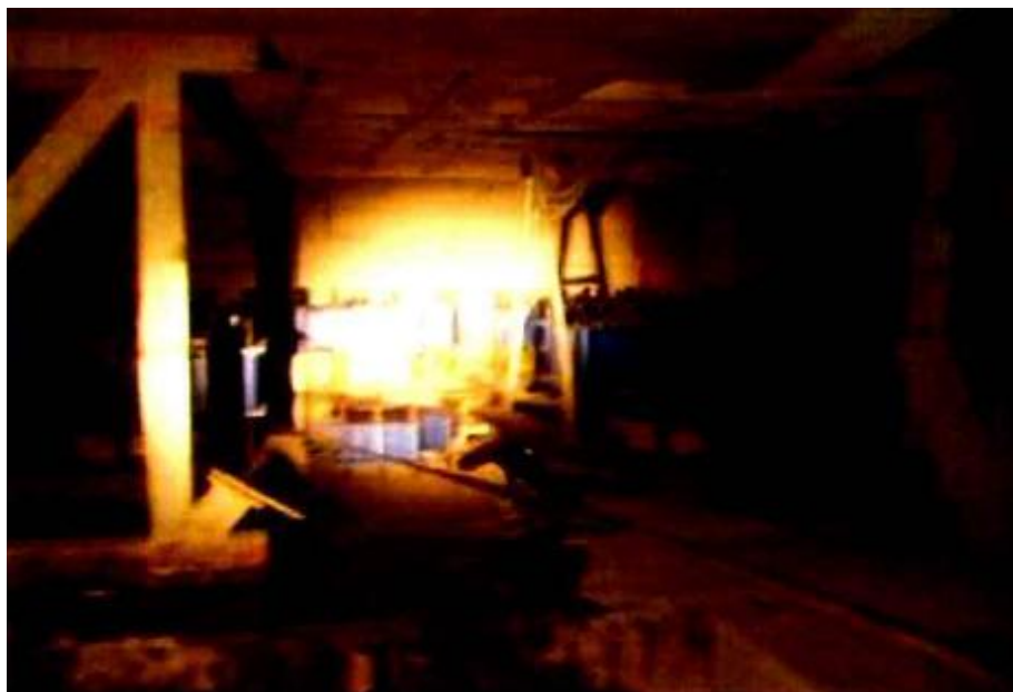
I.18. Interior del inmueble, Sótano 1
