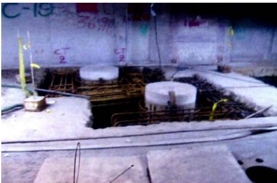
I.13. Interior del inmueble, Sótano 1
