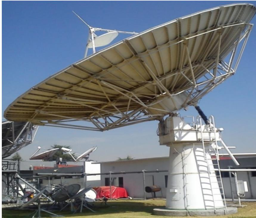
Fig. 3-2 Antena Parabólica tipo Cassegrain
