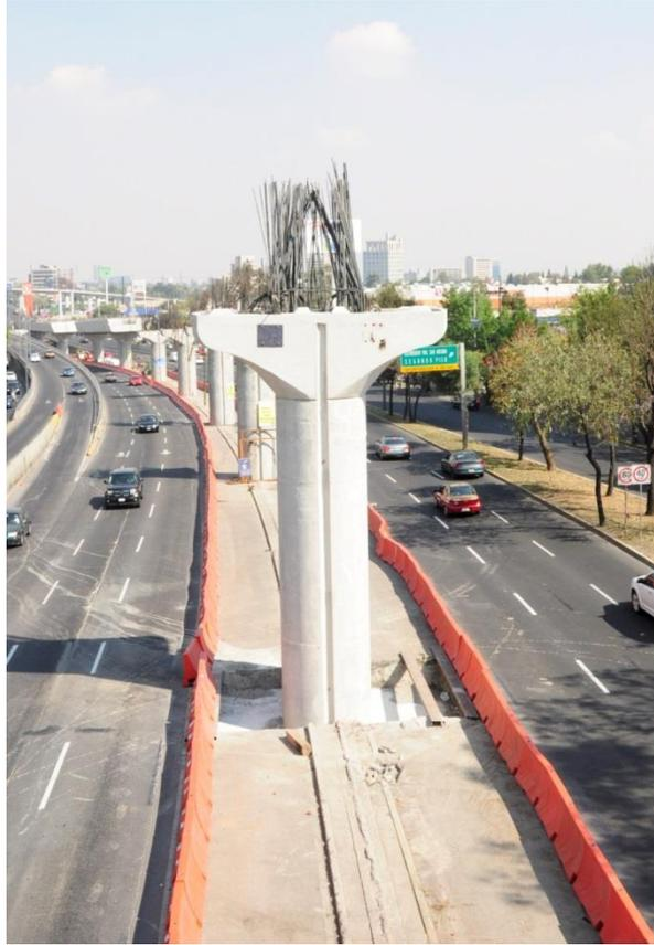
**Ilustración 20. Columna y cabezal.**
