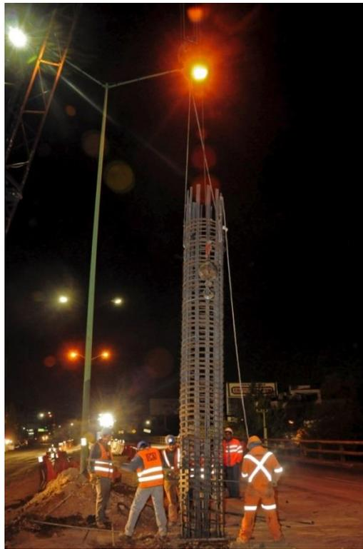
**Ilustración 17. Proceso para realizar pilas.**
