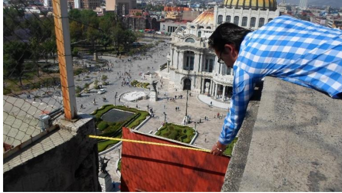
Figura 2.8 Determinación de la separación existente en relación al edificio contiguo en el nivel 11, cuya posición se indica circulada en la figura anterior.
