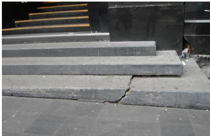
Figura 2.9 Consolidación del suelo que provocó la fractura de los escalones.
