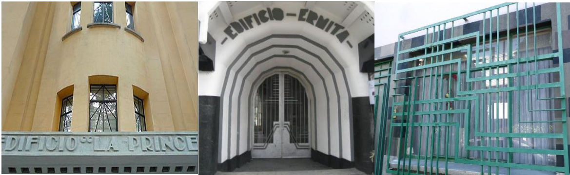
Figura 2.3 Art déco. Ventanería, Edificio La Princesa. Acceso, edificio Ermita. Herrería, Col. Condesa. (Ciudad de México).
