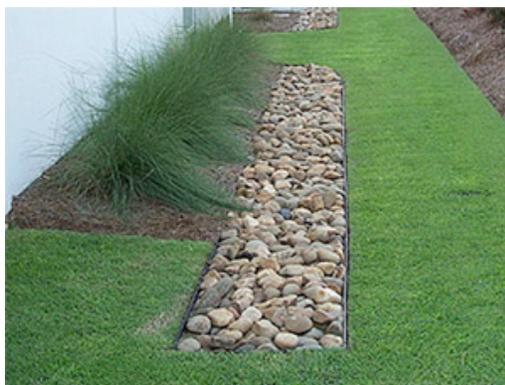
Figura 3-7. Zanja de infiltración. Fuente: sudswales.com
