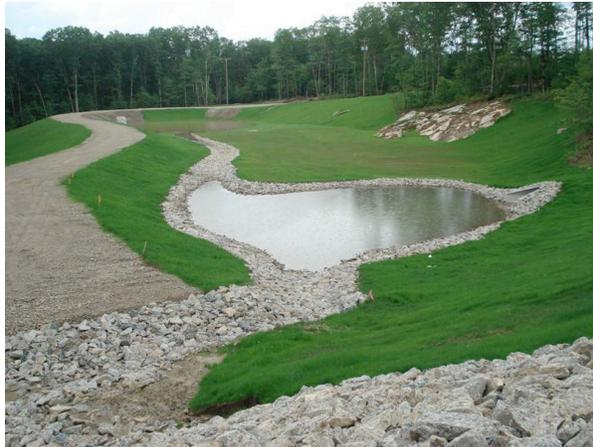
Figura 3-8. Cuenca de infiltración. Fuente: kenmarkturf.com
