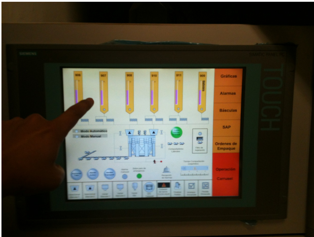
Figura 3.59.- Imagen de la pantalla táctil (PC Touch IPC577c) la cuál sustituirá a la botonera.
