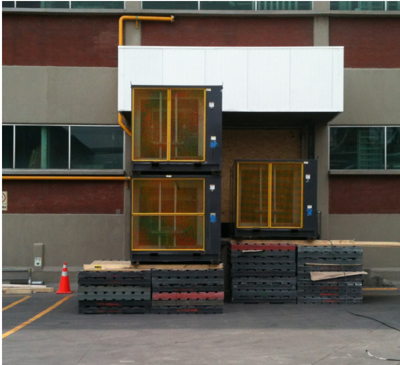
Figura 3.50.- Disposición final de los calentadores (Heaters)
