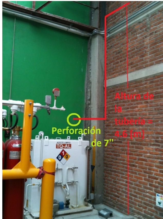
Figura 3.48.- Perforación por donde sale la tubería del cuarto de generación.
