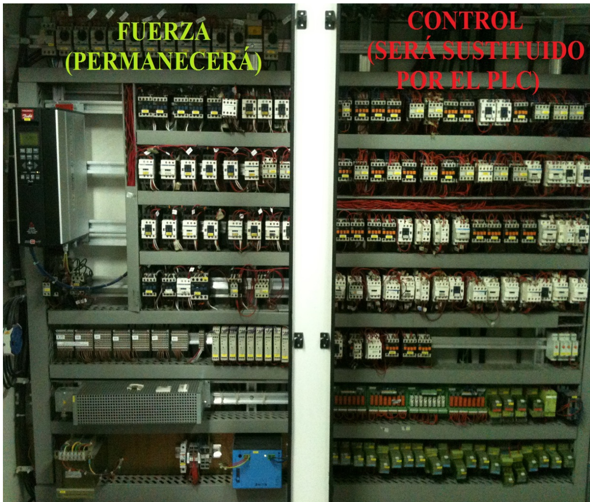
Figura 3.54.- Tablero T907 en donde se ubican todos los elementos tanto de fuerza como de control del Carrusel.
