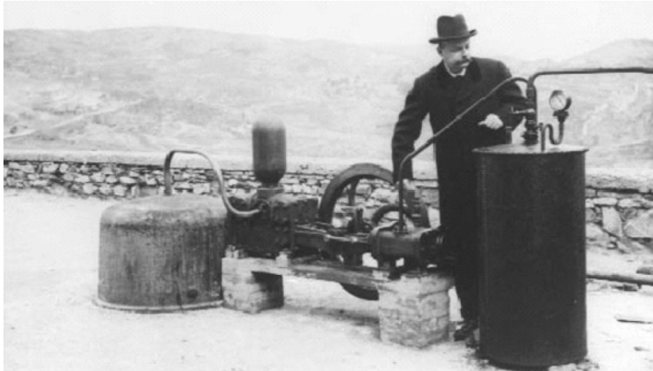
Fig. 1 Primer sistema de generación eléctrica con geotermia [3].
