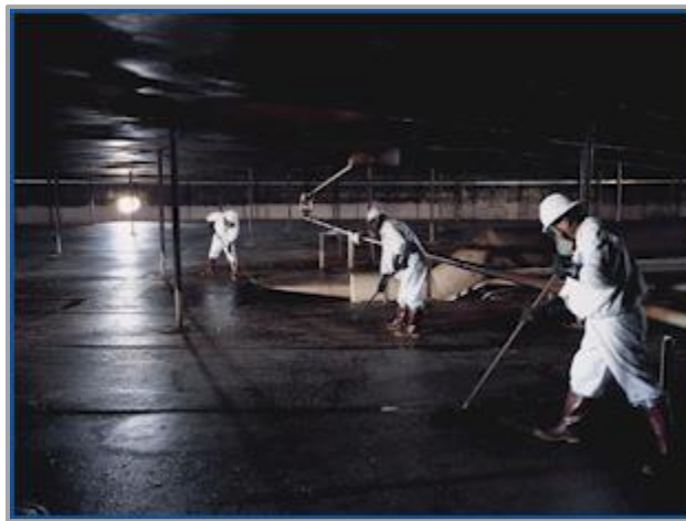
Figura 1. Limpieza manual de tanques.
