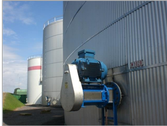
Figura 35. Colocación de agitador de entrada lateral en tanques de almacenamiento.
