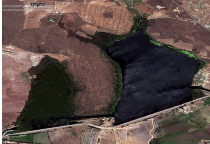
Ilustración 1.1. Diques Batamote y Arroyo Prieto.
