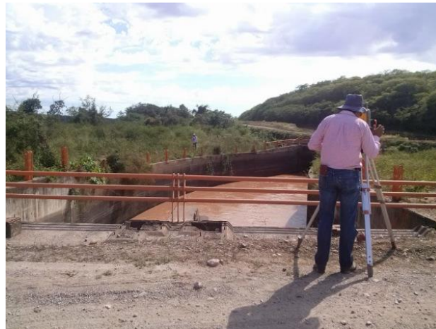
Fotografía 6.7. Levantamiento de estructura.
