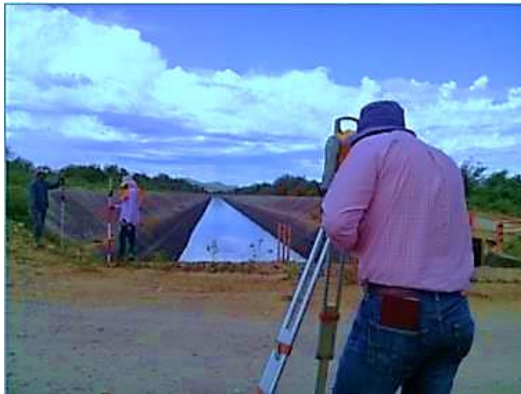
Fotografía 6.5. Levantamiento en planta del canal e infraestructura.
