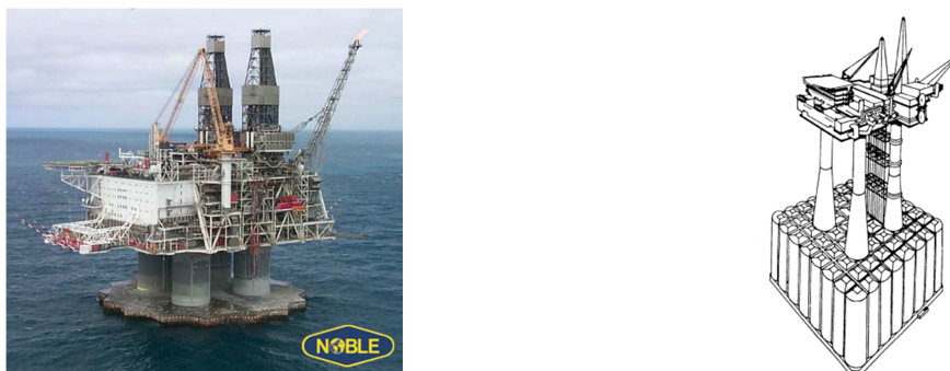
Figura 2. 4. Plataforma de base de gravedad.
