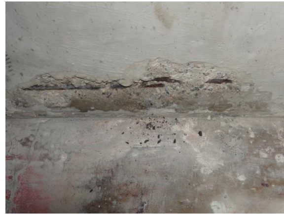
Fig. 2.14 Columnas del semisótano que presentan acero de refuerzo expuesto en la base con indicios de corrosión.
