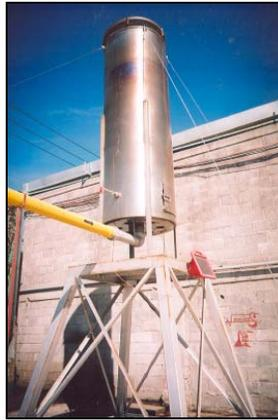
Figura 6.6 Quemador de Biogás (Bioverde, 2009)
