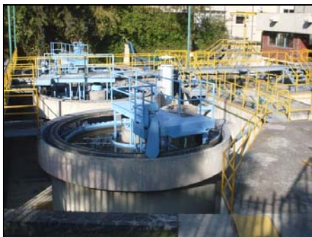
Figura 5.3 Sedimentadores secundarios
