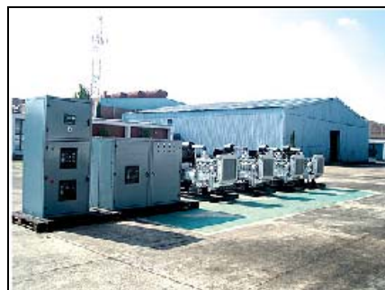
Figura 4.3 Sincronía entre varios motogeneradores (Mopesa, 2009)
