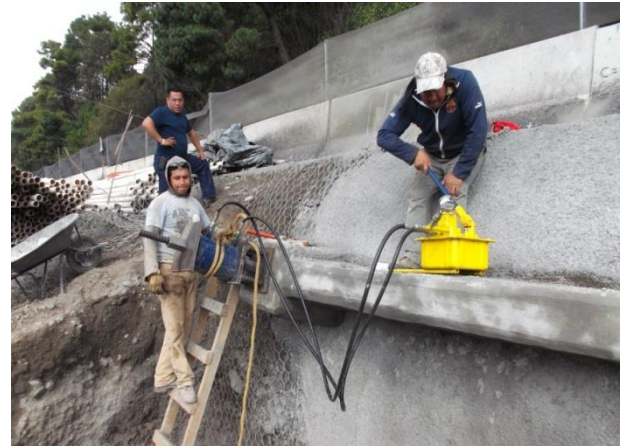
Imágenes 17 y 18 Tensado de las anclas posterior al fraguado de traveses y dados
