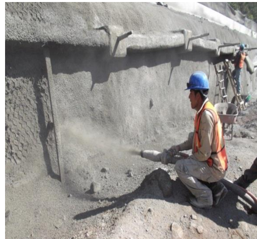
Imágenes 15 y 16 Labrado y colocación de dados y lanzado de concreto lanzado
