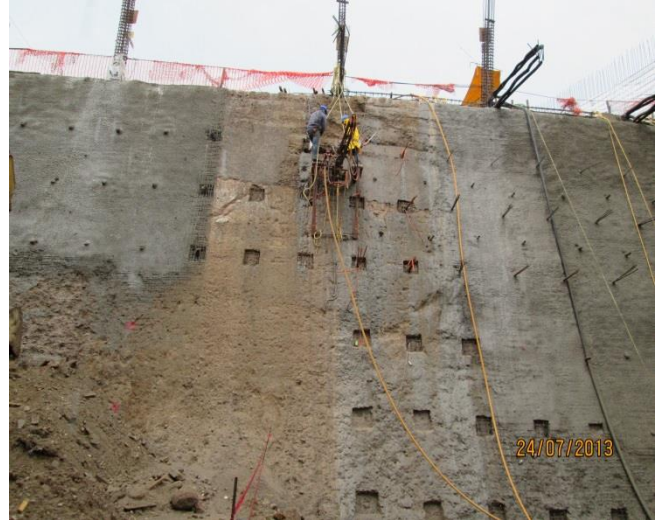
Imagen 1 y 2 Perforación con perforadora neumática tipo Stenuick
