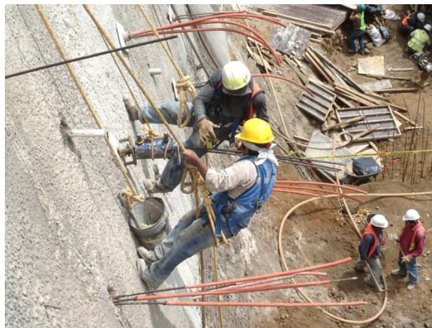
Imagen 7 Tensado del ancla con gato hidráulico de 50 toneladas en ciclos de carga
