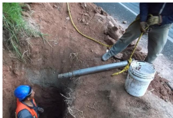
Imágenes 21 y 22 Excavación de pozo para localizar el martillo perdido durante la perforación
