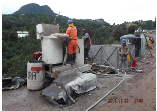
Imágenes 13 y 14 Inyección del ancla y equipo utilizado para la misma
