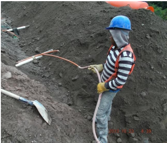
Imágenes 13 y 14 Inyección del ancla y equipo utilizado para la misma
