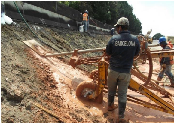
Imágenes 23 y 24 Perforación con bentonita espesa para dar solución a problemas de caídos y colocación de mortero pobre en el barreno
