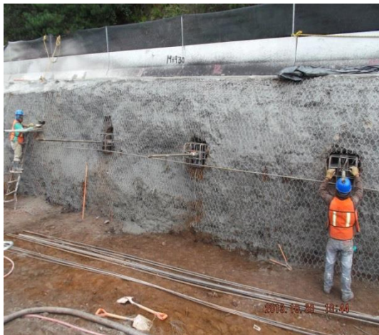
Imágenes 15 y 16 Labrado y colocación de dados y lanzado de concreto lanzado
