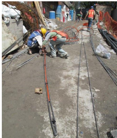
Imagen 3 Habilitado del ancla en patio aledaño
