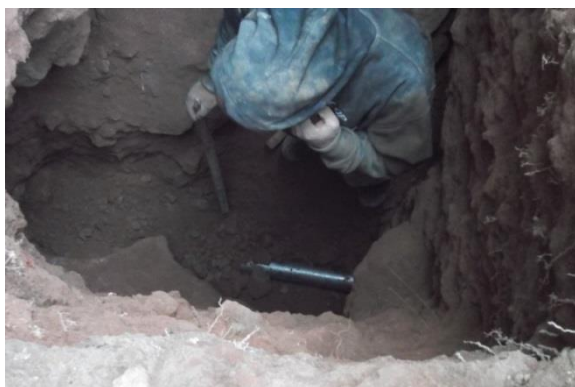
Imágenes 21 y 22 Excavación de pozo para localizar el martillo perdido durante la perforación
