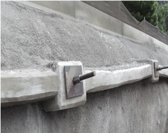
Imágenes 17 y 18 Tensado de las anclas posterior al fraguado de traveses y dados
