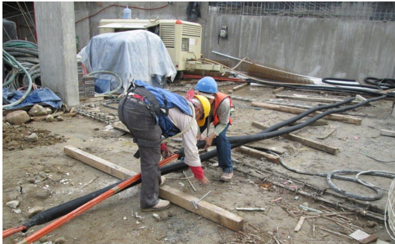
Imagen 4 Colocación del ancla arrastrándola desde la parte superior para introducirla en el barreno
