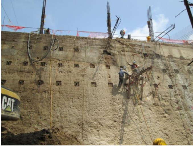
Imagen 1 y 2 Perforación con perforadora neumática tipo Stenuick
