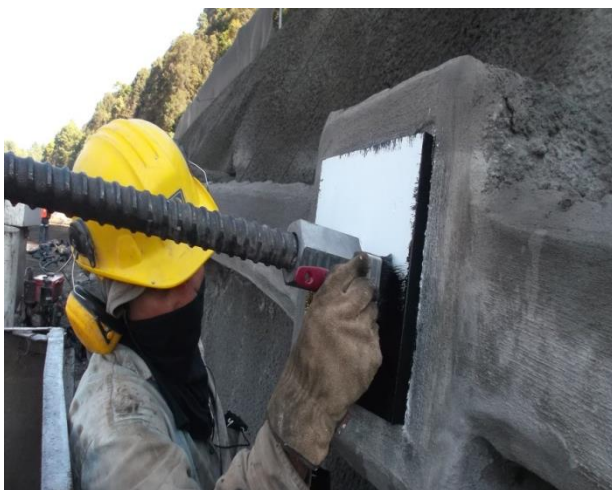
Imagen 19 y 20 Detalles finales y colocación de capuchón de PVC
