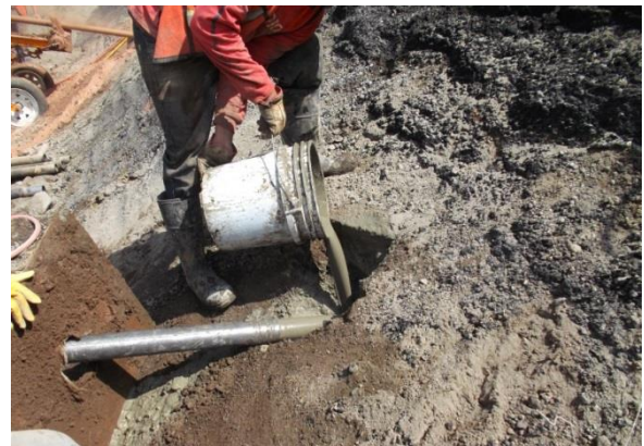
Imágenes 23 y 24 Perforación con bentonita espesa para dar solución a problemas de caídos y colocación de mortero pobre en el barreno
