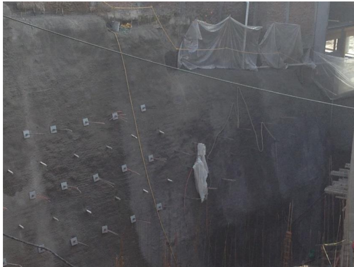
Imagen 6 Recubrimiento del corte con concreto lanzado
