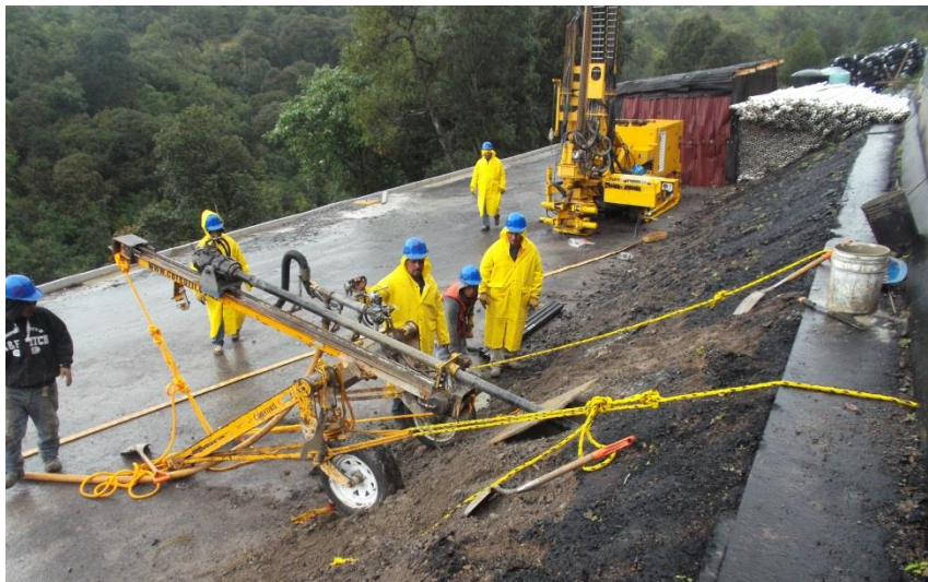
Imagen 10 Perforación con maquina tipo Core Drill neumática
