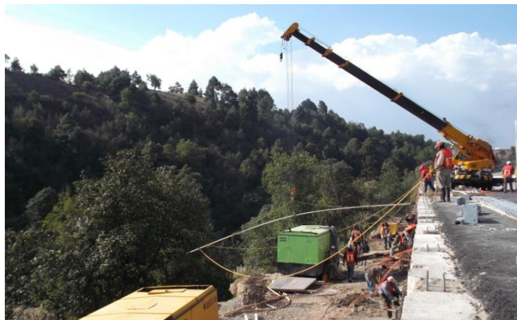
Imagen 26 Instalación de anclas con ayuda de una grúa
