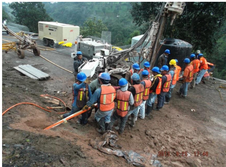
Imagen 12 Colocación del ancla dentro del barreno
