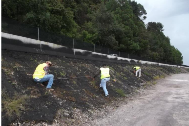
Imagen 9 Ubicación de puntos para perforación de anclas y drenes
