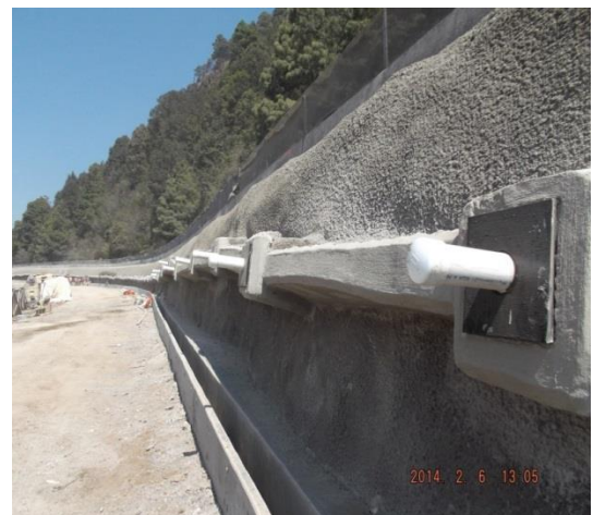
Imagen 19 y 20 Detalles finales y colocación de capuchón de PVC
