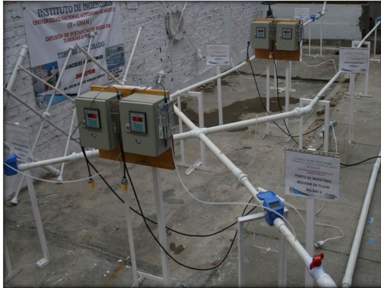
Figura 3.8. Dispositivo físico construido [cruces de 90°]
