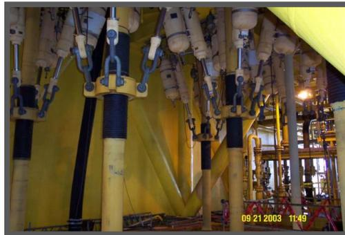
Figura 4.33 Tensionadores y risers en instalación flotante.
