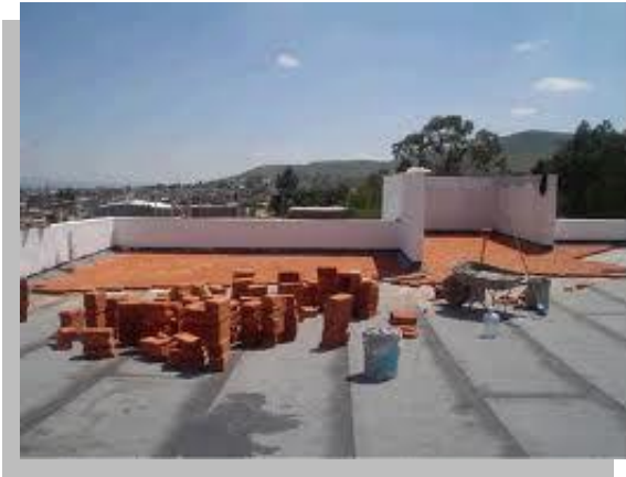
Fig. 10 y 11.- Del lado izquierdo se puede apreciar la construcción del sistema impermeable a base de enladrillado mientras que del lado derecho se observa un trabajo terminado.
