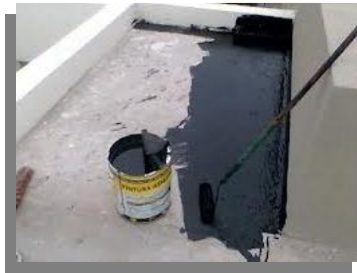
Fig. 4.- Imprimación de una superficie a impermeabilizar.
