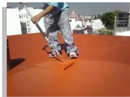
Fig. 18.- Aplicación de un impermeabilizante Elastomérico.
