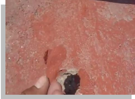
Fig. 19 y 20.- Una de las principales desventajas de los impermeabilizantes acrílicos, es el fácil desprendimiento que presentan al cabo de cierto tiempo a causa de la intemperización.
