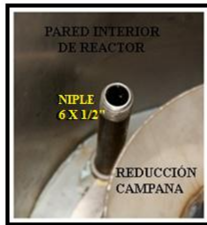
Figura 4.5 Fotografía de boquillas de entrada de aire
