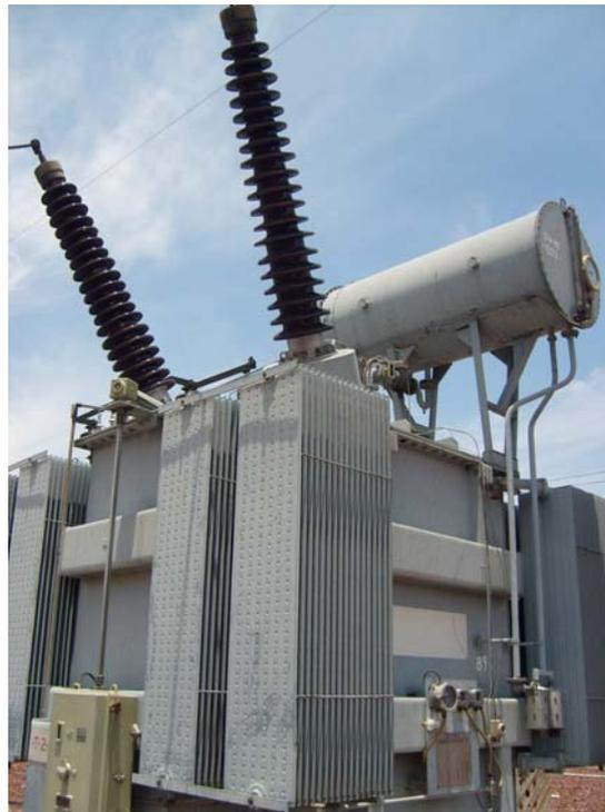
**Figura 1.2.29:** Transformador de tracción de Subestación Eléctrica Tultitlán.
