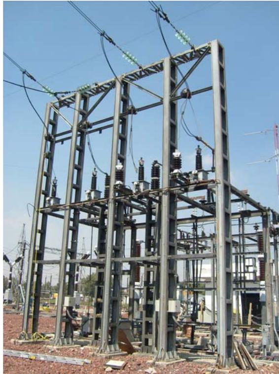
**Figura 1.2.32<sup>1.6</sup>:** Portal de feeders a catenaria.
