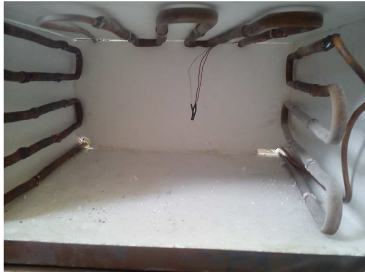
Figura 30 Fotografía de los evaporadores para la segunda configuración.
