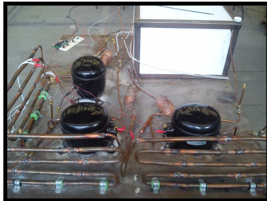
Figura 26 Banco de pruebas ensamblado e instalado.
