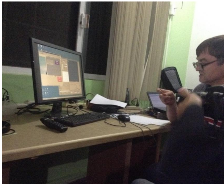
Figura 59 La interfaz de usuario instalada en una computadora de la sala de control.
