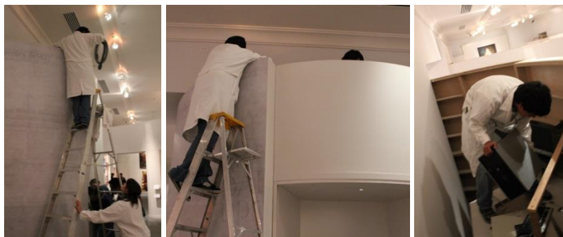
Figura 57. Instalación del sistema de monitoreo.
