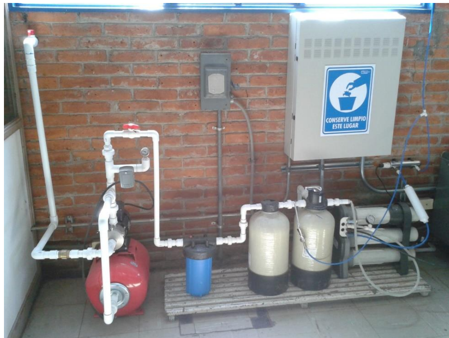
Figura 69. Planta de tratamiento de la Planta Solar del II-UNAM para obtener agua desionizada.
