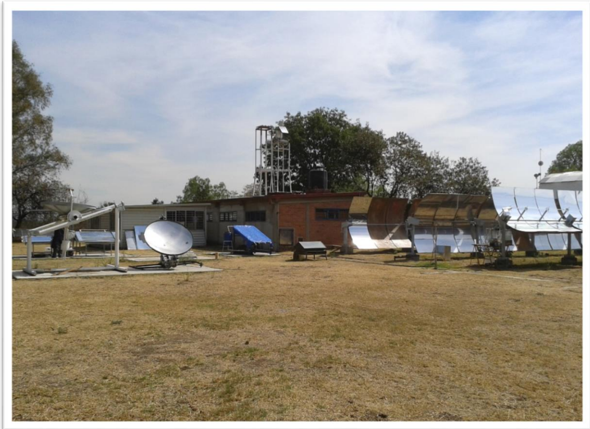
Figura 5. Vista de la Planta Solar del Instituto de Ingeniería de la UNAM.
