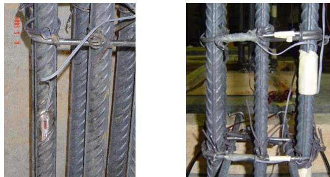
Figura 2.9 Instrumentación interna de los barras de refuerzo
