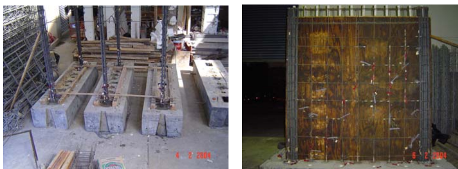
Figura 3.1 Construcción de los muros y su instrumentación
