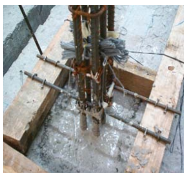
Figura 2.4 Fijación de las barras verticales del núcleo en la cimentación
