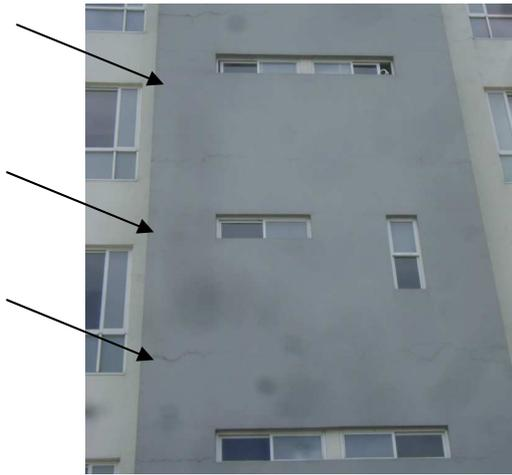
Fotografía de edificio Bilbao fachada 4, en el cual podemos observar las fisuras horizontales.
