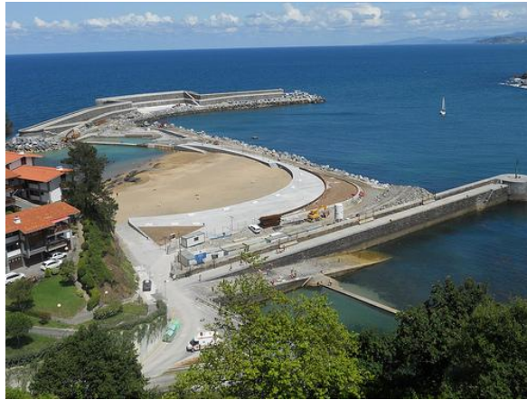
Figura 3.11 El puerto de la localidad vasca de Mutriku con la central instalada en la parte exterior del dique [Ortubia, 2008]
