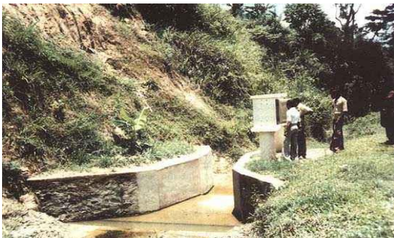
Lámina 2.19 Canal de aforo Parshall con un caudal libre y un registrador de caudal.
