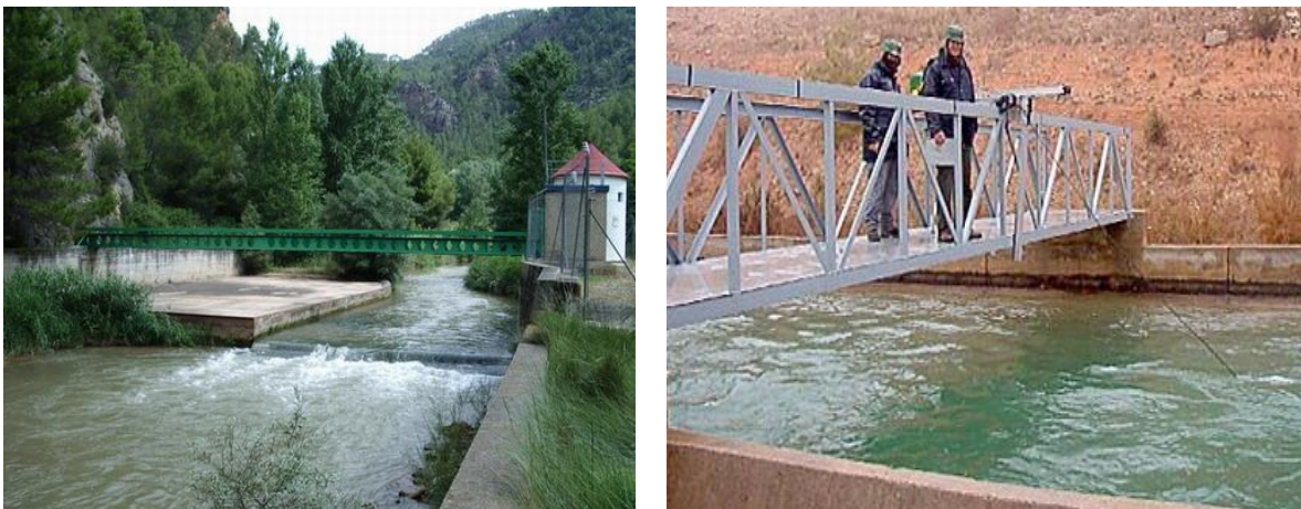
Lámina 2.2 Aforo en puentes peatonales con el método de molinetes.
