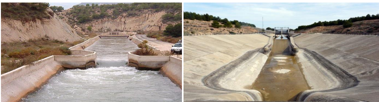
Lámina 2.18 Aforador de garganta larga
