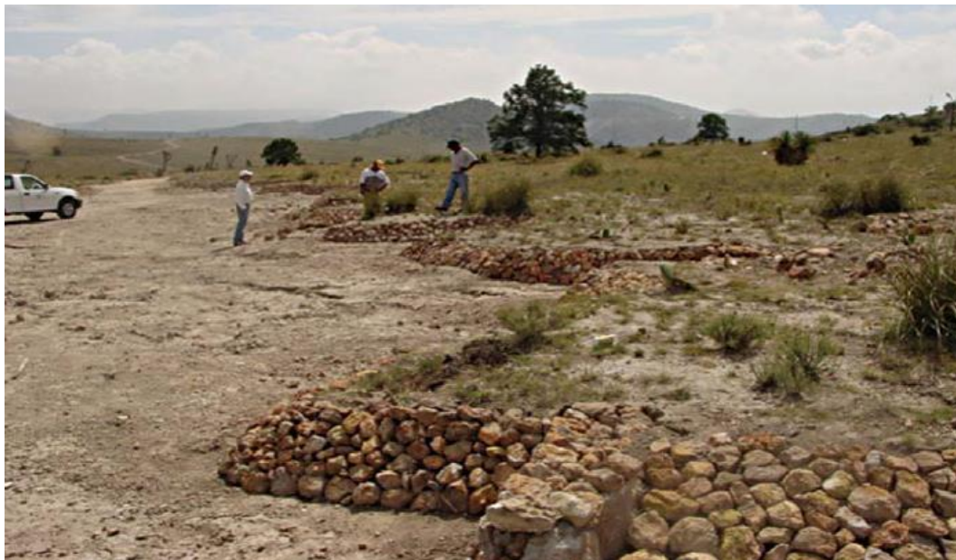
Figura D.31. Estabilización de Taludes. (Cardoza, et al., 2007).
