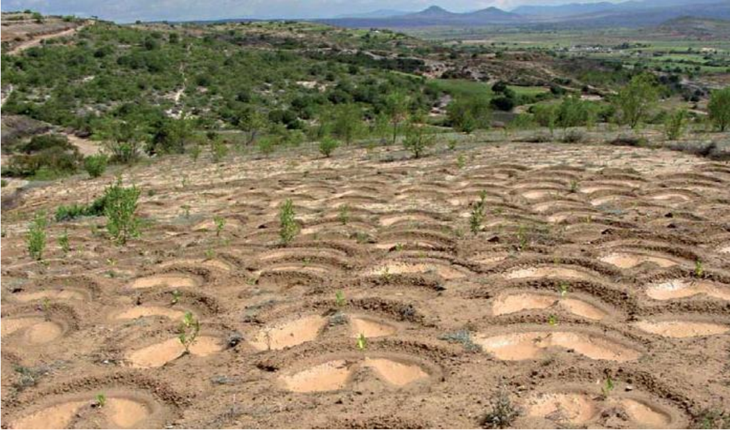
Figura D.4. Terraza individual. (Cardoza, et al., 2007).
