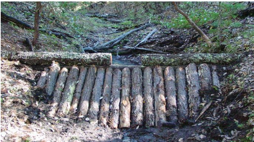
Figura D.23. Presa de morillos. (Cardoza, et al., 2007).
