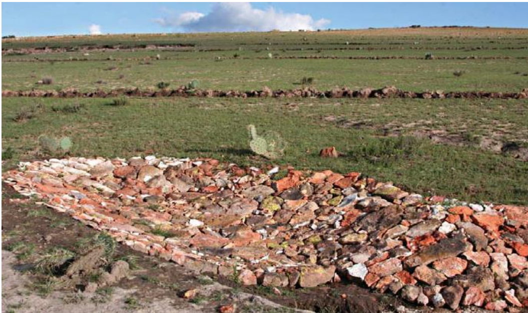
Figura D.30. Cabeceo de cárcavas. (Cardoza, et al., 2007).
