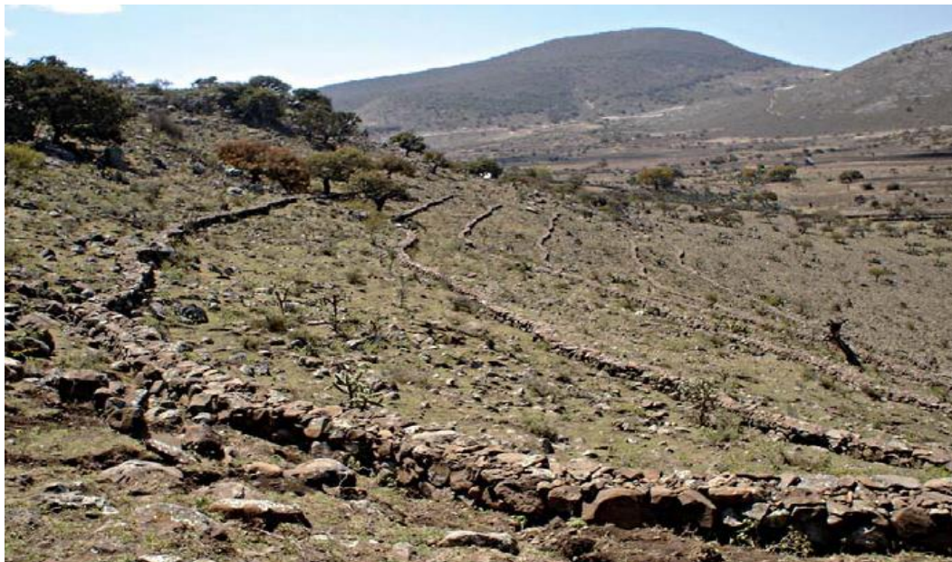
Figura D.5. Barrera de piedra en curva a nivel. (Cardoza, et al., 2007).
