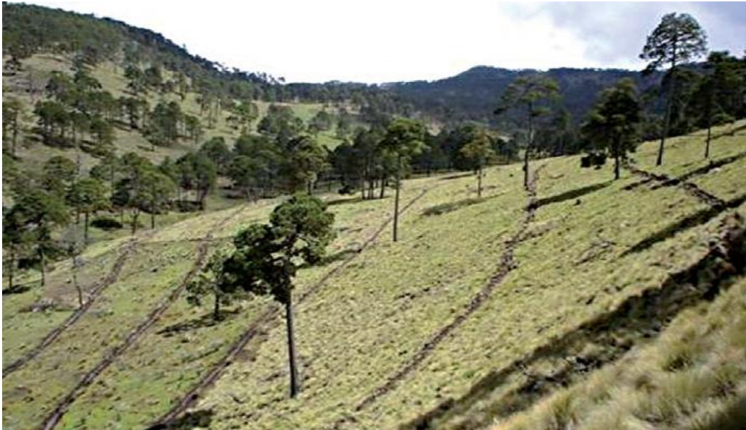
Figura D.7. Zanja bordo. (Cardoza, et al., 2007).
