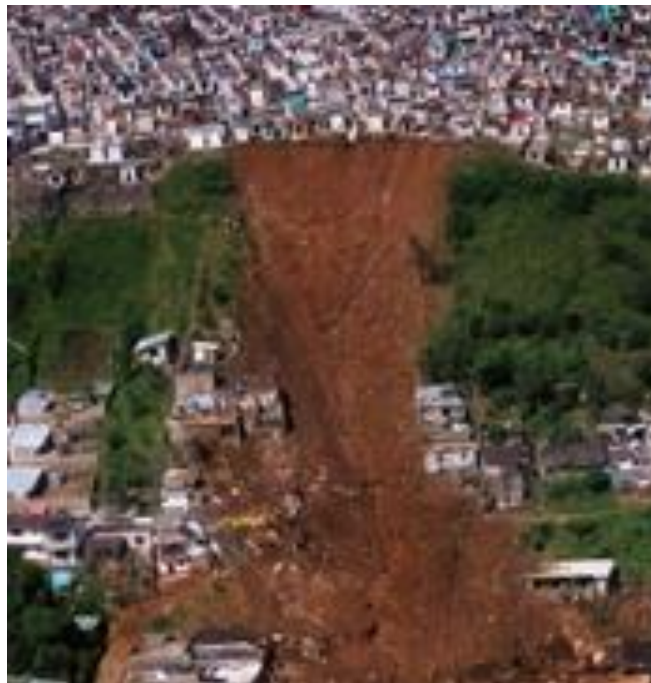
Figura I.2. Flujo de lodo en la colonia La Aurora en el municipio de Teziutlán, Puebla provocado por la precipitación extraordinaria asociada a la depresión tropical número 11 el 5 de octubre de 1999. (Alcántara).
