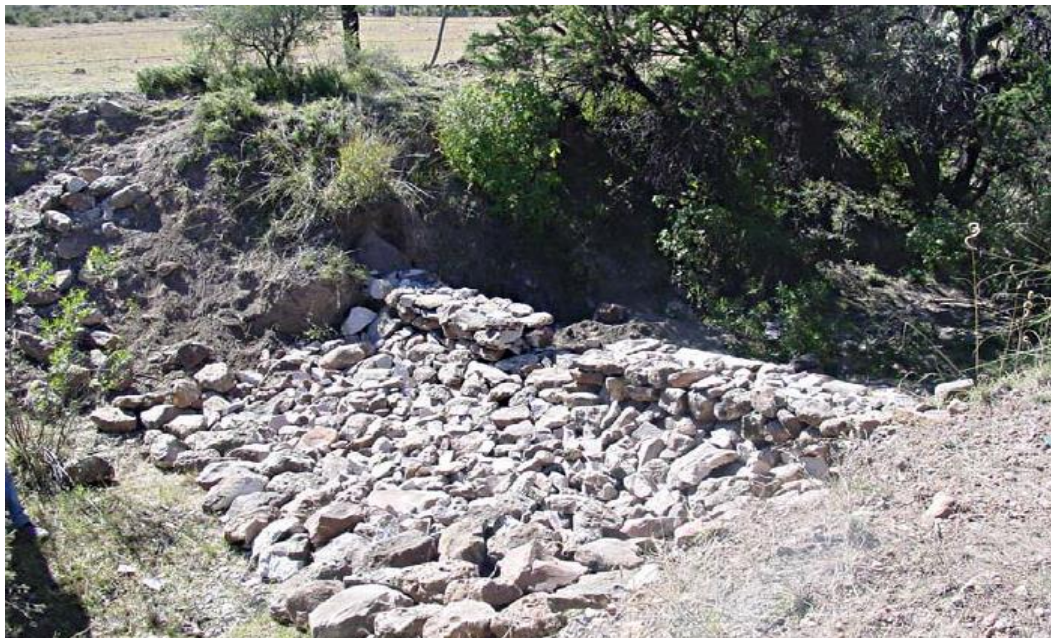
Figura D.25. Presa de piedra acomodada. (Cardoza, et al., 2007).
