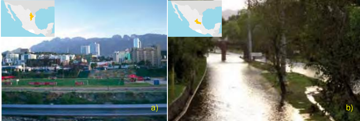
Figura 3.2 a) Canchas deportivas en el área inundable por el río Santa Catarina, N. L., b) Boulevard sobre el cauce del río Santiago, S. L. P. el cual se cierra durante una crecida (CONAGUA, 2011a)
