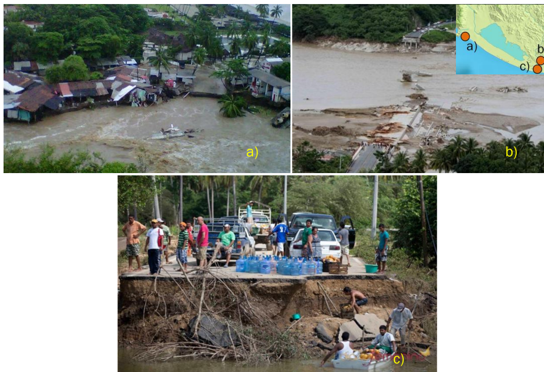
Figura 4.16 a) Flujo en la zona de comercios en Playa Revolcadero, b) Puente en Lomas de Chapultepec destruido, c) Puente Barra Vieja-Lomas de Chapultepec (Internet)
