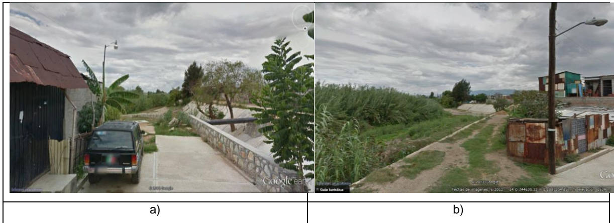
Ilustración 7.1 a) Vista de aguas arriba hacia aguas abajo del río Atoyac y b) Bordo construido para protección de las personas.
