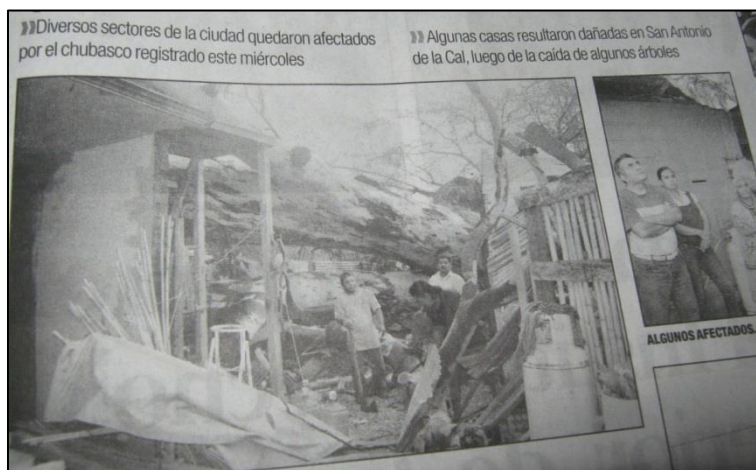
Ilustración 1.15 Daños provocados por chubascos en la periferia de la ciudad de Oaxaca
