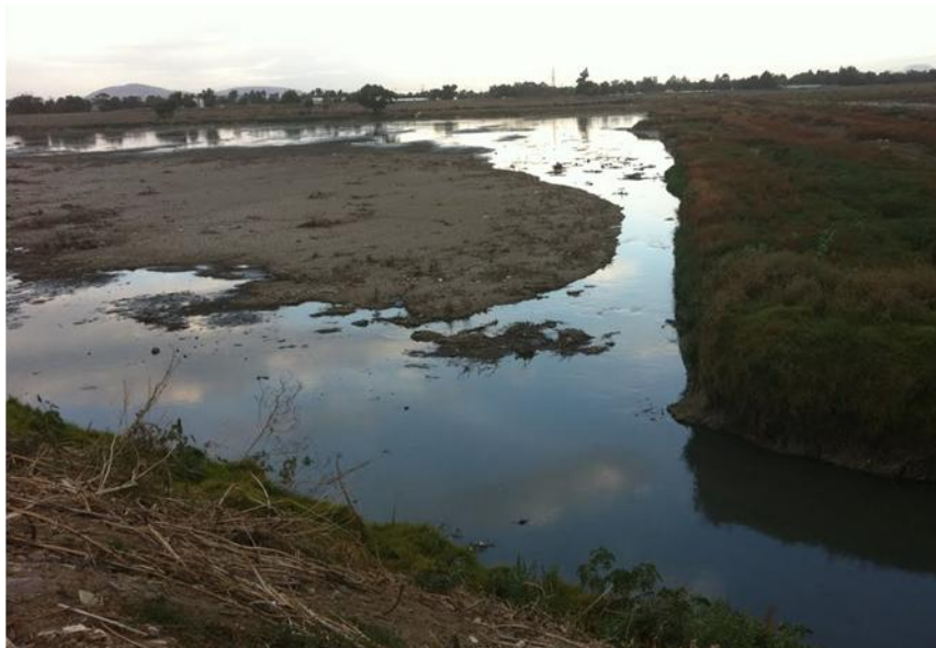
Figura 3.11. Vista panorámica del Vaso regulador del Cristo.
