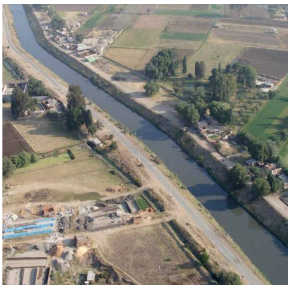
Figura 3.6. Vista aérea del gran canal de desagüe.
