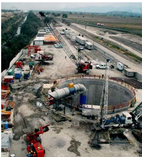
Figura 3.9. Lumbrera del Túnel Emisor Oriente.
