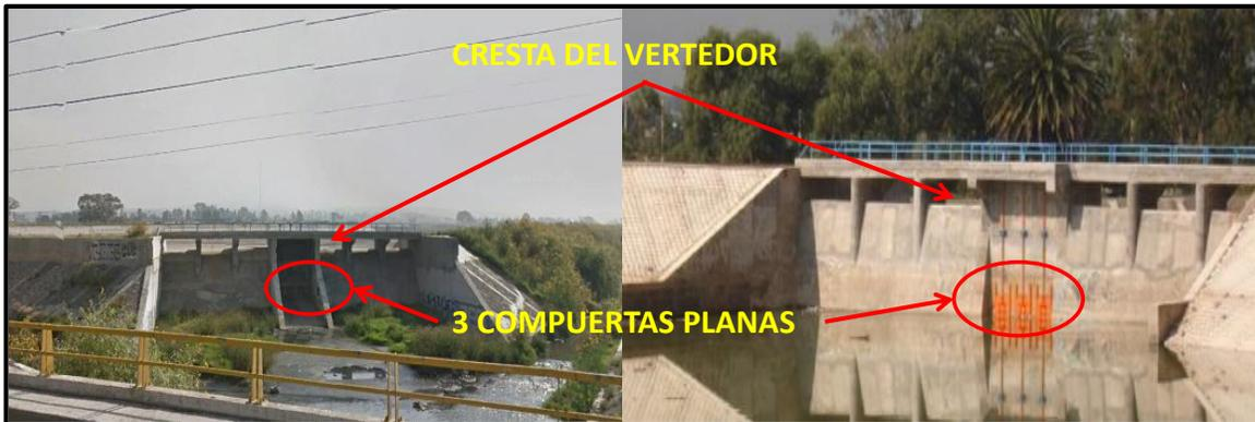
Figura 3.5. Estructura de descarga de la laguna de regulación La Gasera, aguas debajo de la descarga (izquierda) y aguas arriba de la descarga (derecha).
