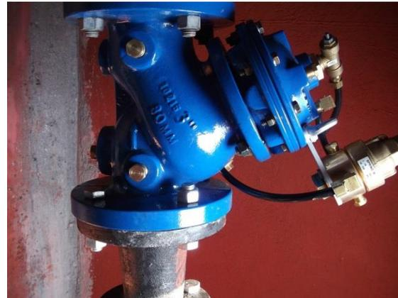
*Figura 5.19 Proceso de instalación de fontanería en sitio de control de presiones.*
