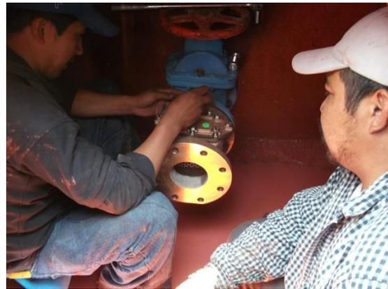
***Figura 5.10 Proceso de instalación de fontanería en sitio de macromedición.***
