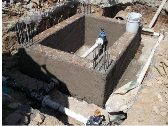
*Figura 5.18 Proceso de obra civil en sitio de control de presiones.*
