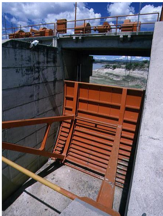
Ilustración 5.8. Compuerta radial de la Presa “Temascal”
