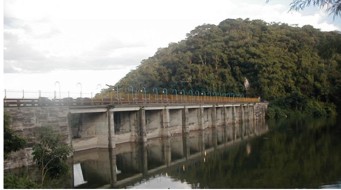
Ilustración 5.6. Vista de la parte posterior de la obra de excedencias de la Presa "Temascal".
