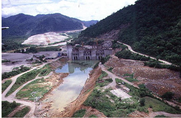
Ilustración 5.9. Construcción de la Presa Miguel de la Madrid “Cerro de Oro”.
