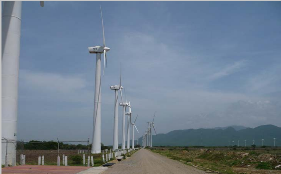
Central eólica de La Venta, Juchitán, Oaxaca
