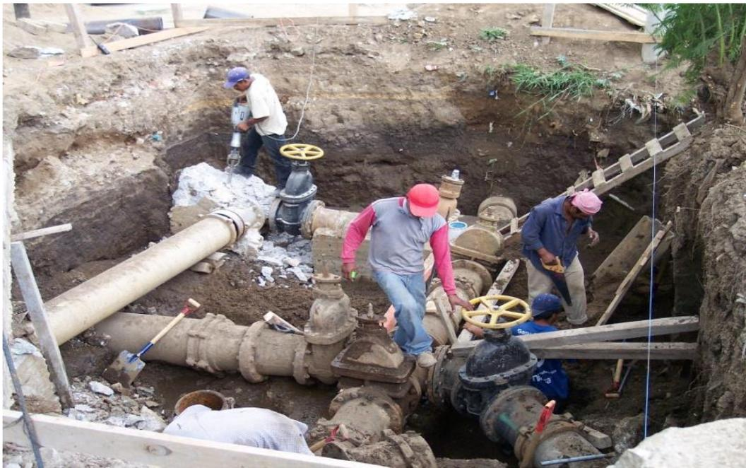
*Figura 2.20 Cruce de tuberías en un sistema de distribución de agua.*
