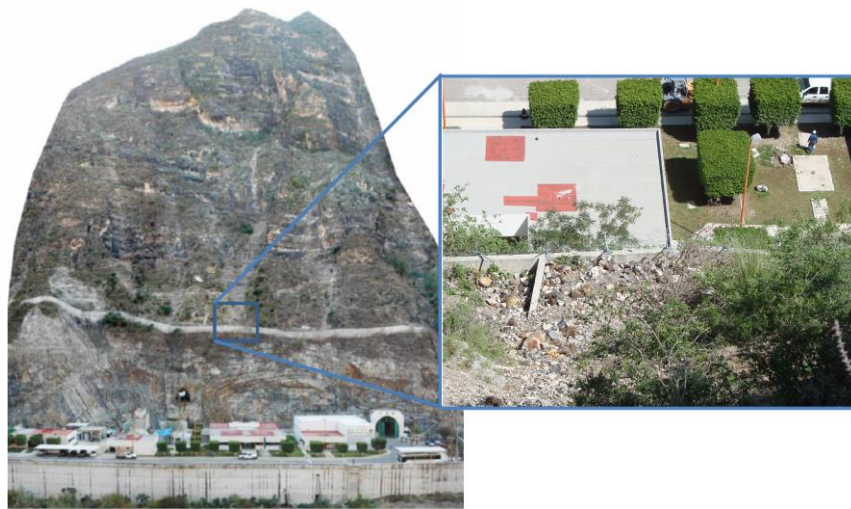
Figura 6.10. Ubicación de la concentración de fragmentos en el muro perimetral.
