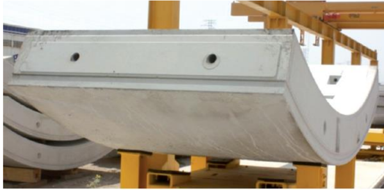
Figura 12. Junta plana típica de una dovela (Peña et al., 2012)
