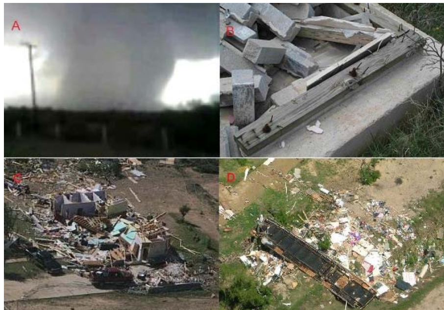
Figura 1. 10. Daños ocasionados por el tornado en Eagle Pass, Texas (Marshall y Eblen)
