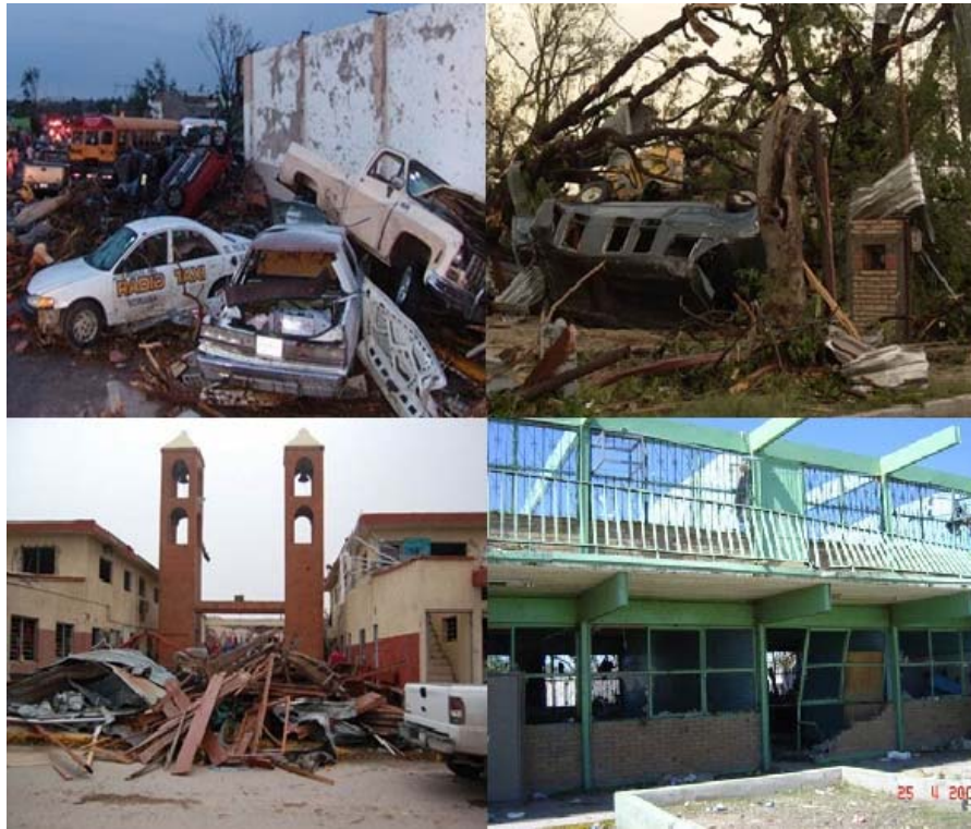
Figura 1. 9. Daños ocasionados por el tornado en Piedras Negras, Coahuila (CENAPRED, 2009)
