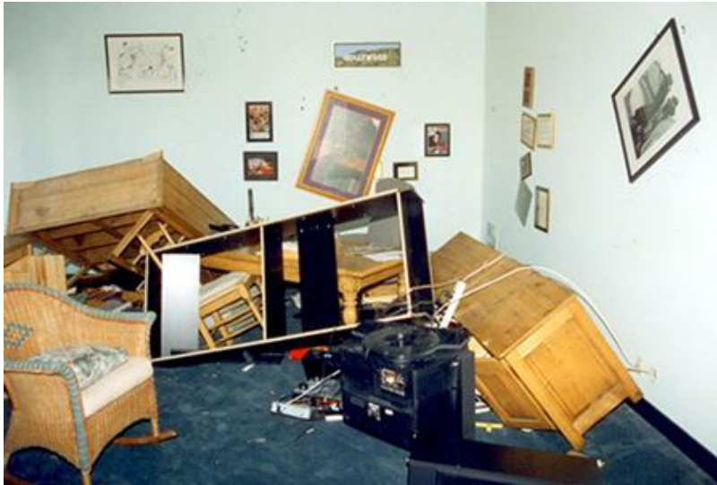
Figura 1.4 Falla inercial en mobiliario Emergencias (FEMA-E74 2013)
