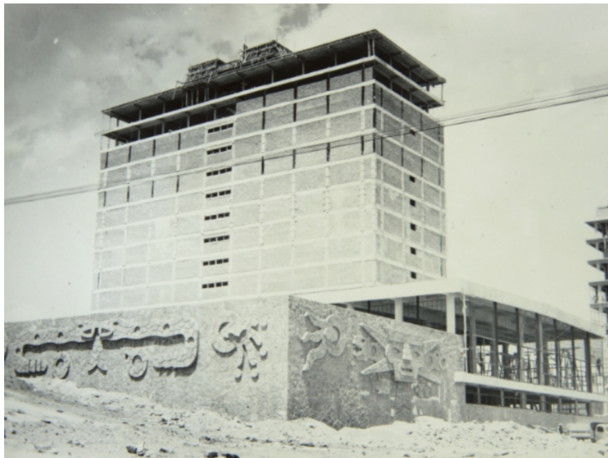
Fuente: Archivo DGOyC. Construcción Biblioteca Central.
