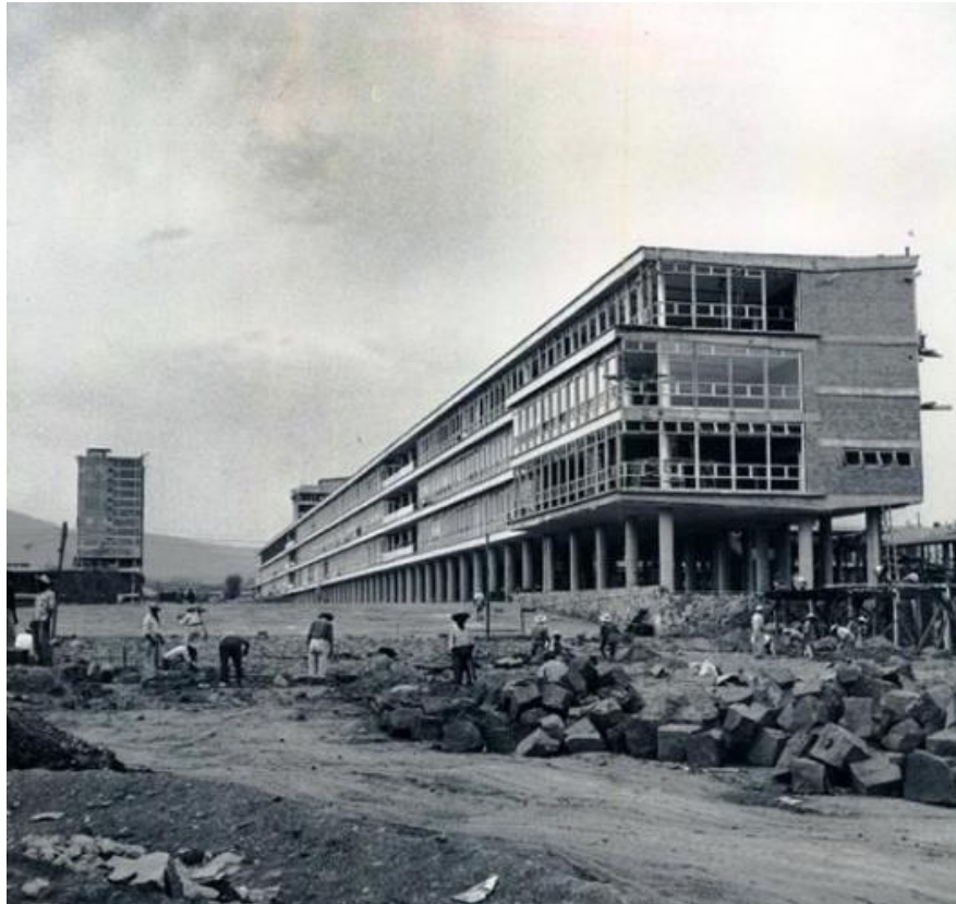
Fuente: Archivo DGOyC. Construcción Facultad de Economía.
