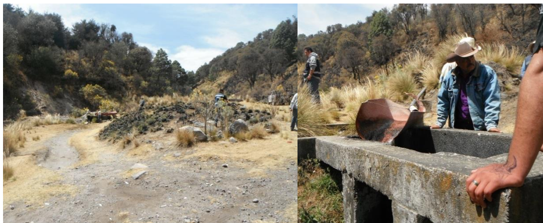
FIGURA A. 2 CAPTACIÓN DE AGUA DE MANANTIAL PARA SUMINISTRO DE AGUA POTABLE A LA POBLACIÓN
