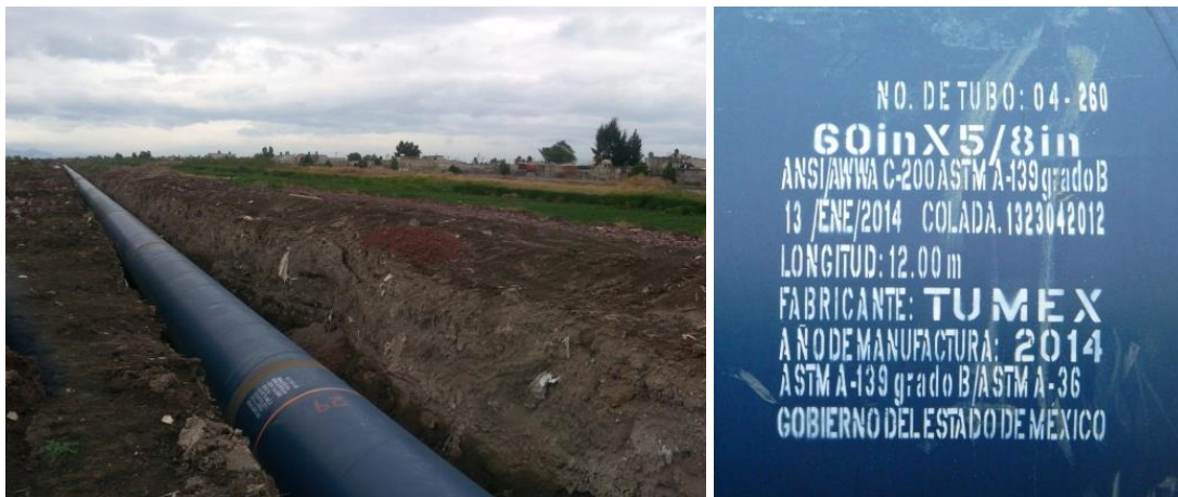
FIGURA A. 4 TUBERÍA DE CONDUCCIÓN DE AGUA POTABLE HECHA DE ACERO HELICOIDAL DE 1.50 M DE DIÁMETRO
