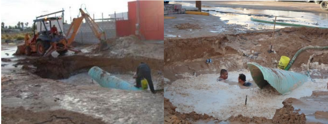
FIGURA 4. 9 REPARACIÓN DE TUBERÍA DE PVC EN FUGA DE AGUA POTABLE APOYADA EN MATERIAL ARCILLOSO
