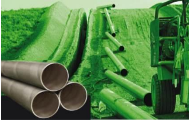
FIGURA 1. 4 TUBERÍA DE ACERO CON COSTURA HELICOIDAL
