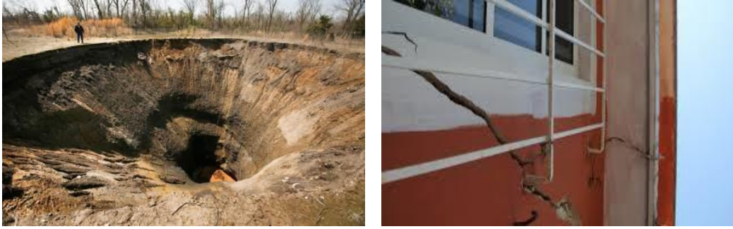
Figura 1.2a y 1.2b Ejemplos de falla catastrófica y de falla por deformaciones excesivas
