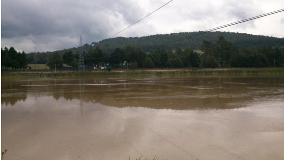
Figura 12. Sitio de disposición de lodos provenientes de la coagulación con sulfato de aluminio en la planta Los Berros
