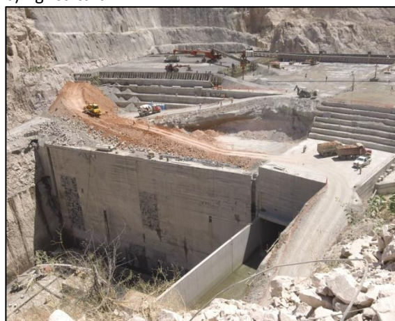
d) Construcción de la presa El Zapotillo
