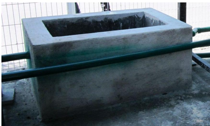
**Figura 3.10 Fotografía del lecho de secado de lodos.**
