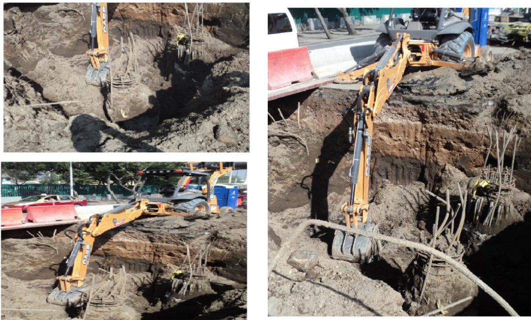
Figura 23. Excavación de material entre pilas
