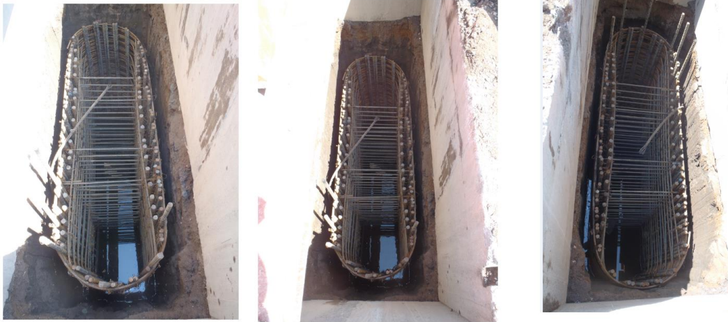
Figura 20. Armado de acero instalado
