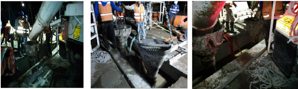
Figura 21. Colado de pilas
