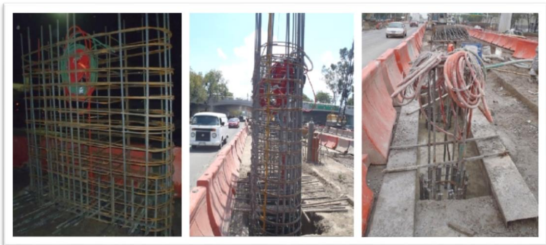
Figura 42. Cables protegidos enrollados en las dos etapas del izaje del armado
