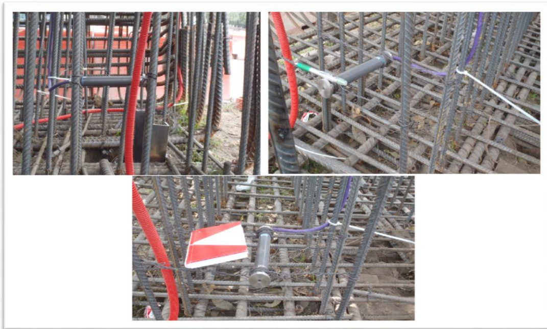
Figura 41. Instalación de deformímetros de puente completo
