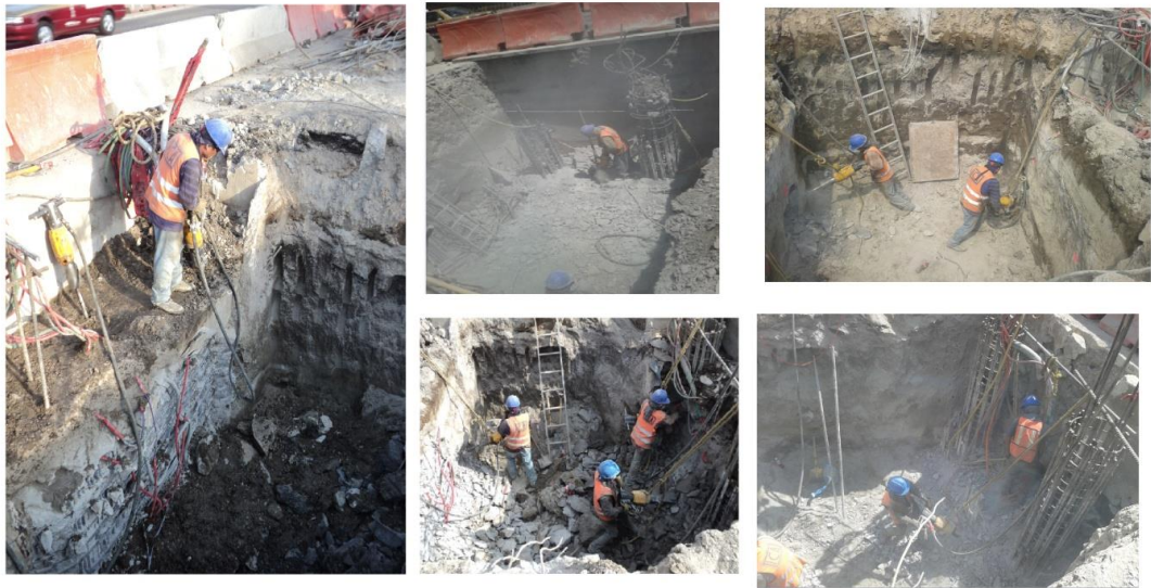
Figura 25. Descabece de pilas
