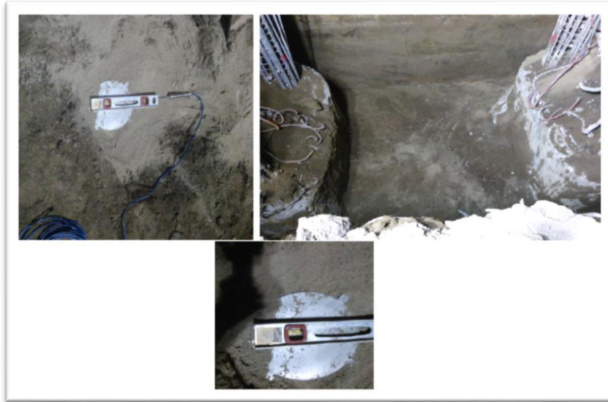
Figura 44. Instalación de celda de presión bajo el mejoramiento
