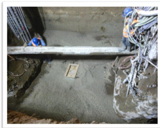
Figura 45. Lugar de instalación de celda bajo la Zapata y sobre el mejoramiento
