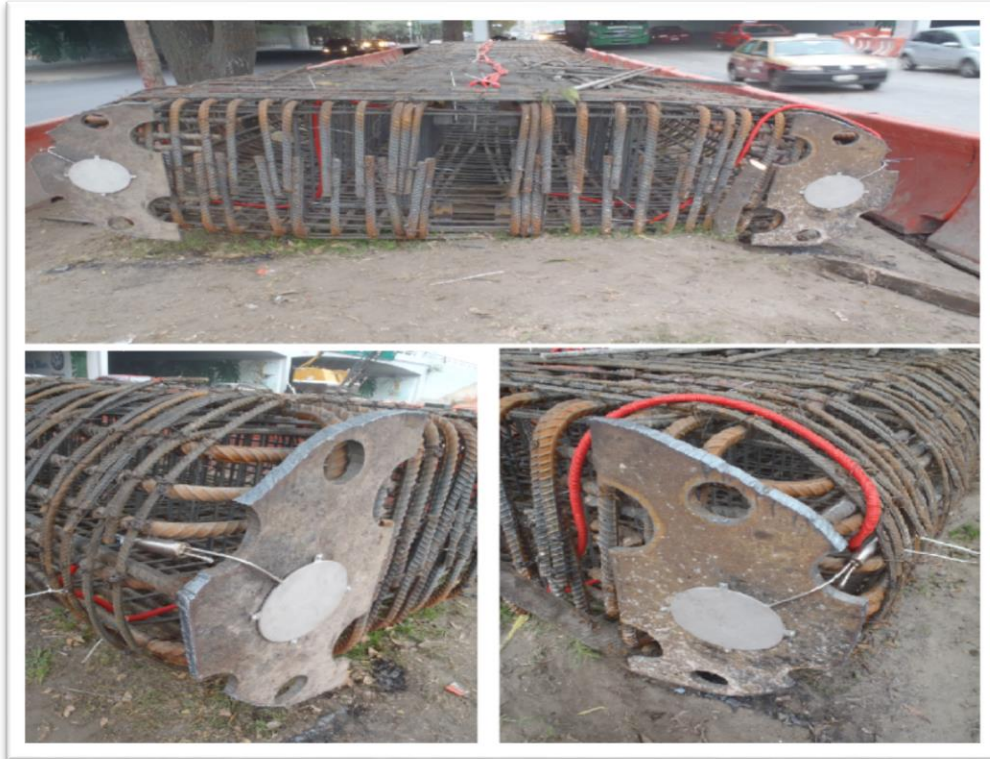
Figura 43. Instalación de celdas de presión en la punta de la pila
