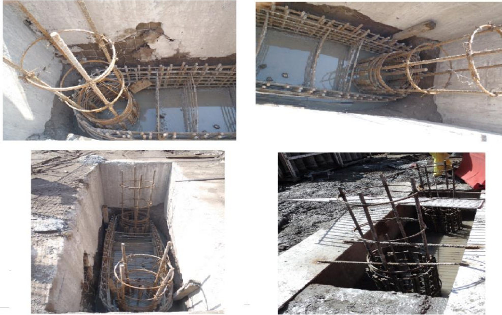
Figura 22. Instalación de las espigas en una pila
