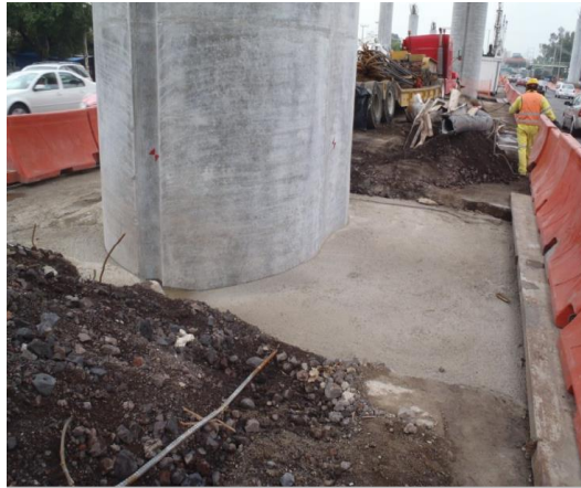
Figura 29. Relleno sobre y a los lados de la zapata
