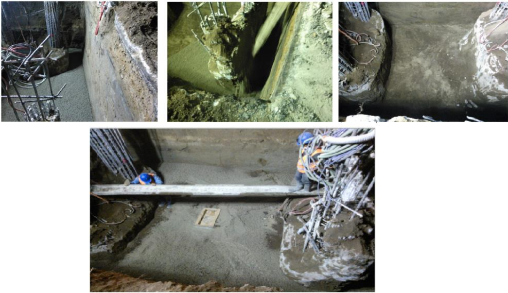
Figura 24. Colado de mejoramiento en concreto
