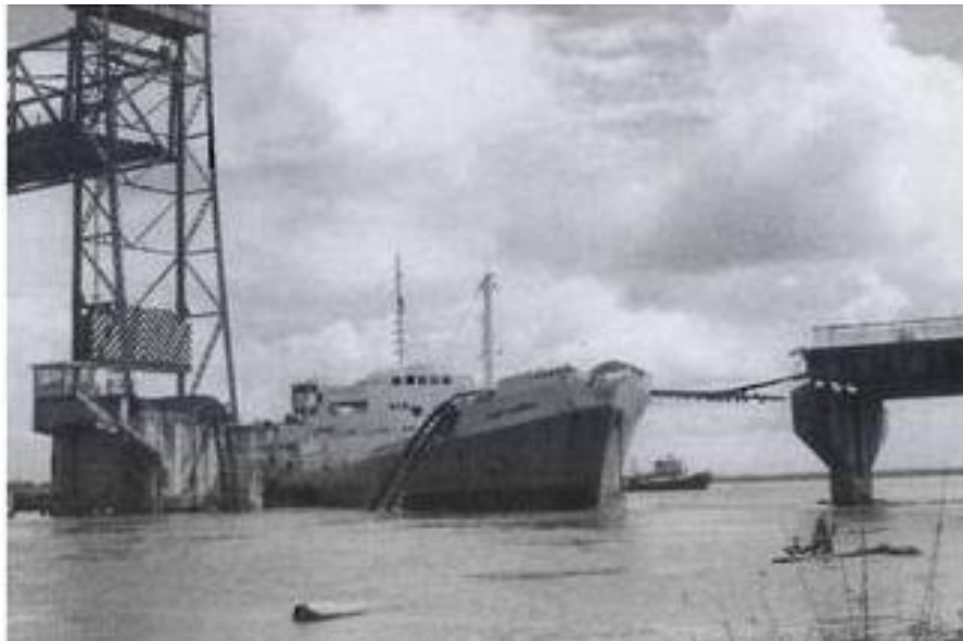
Figura 1.9. Colisión de una embarcación con el puente Coatzacoalcos I [1.3].
