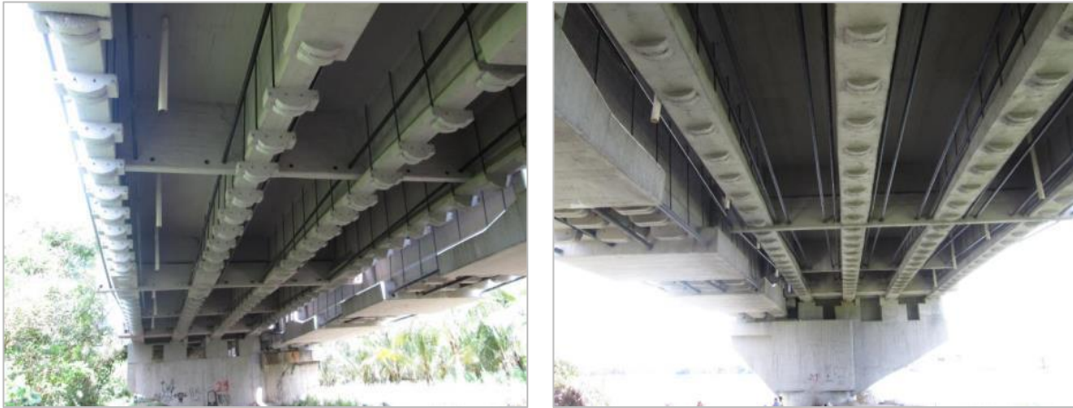
Figura 1.14. Refuerzo longitudinal de las traveses a flexión del tramo carretero [1.3].
