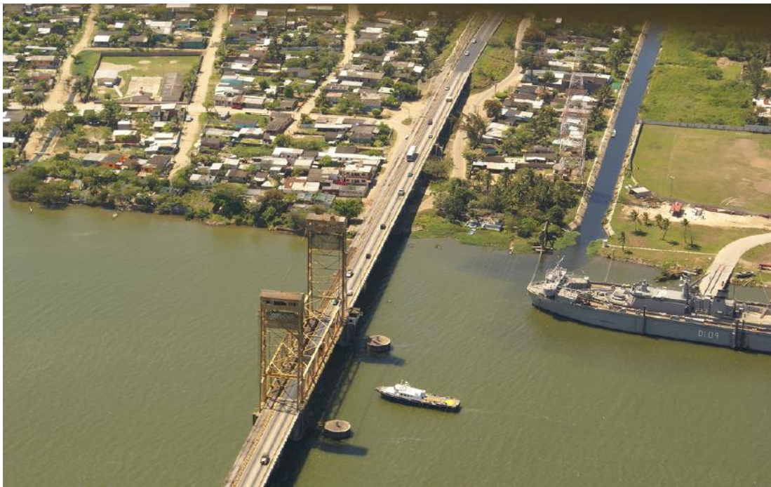
Figura 1.1. Vista parcial del puente Coatzacoalcos I, se observa el tramo metálico levadizo [1.1].
