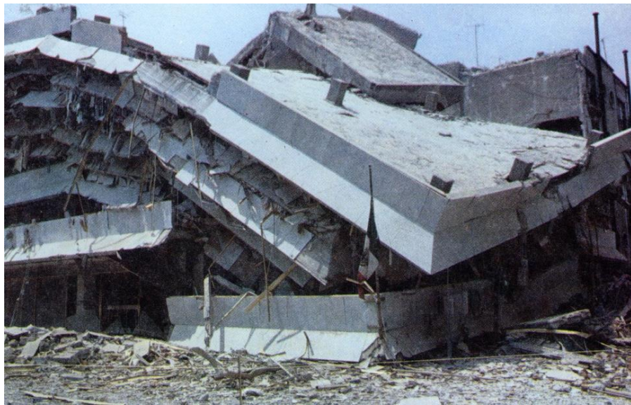
Figura I-5 Daños debidos al sismo de septiembre de 1985 en diversos edificios de la Ciudad de México construidos con losas planas.
