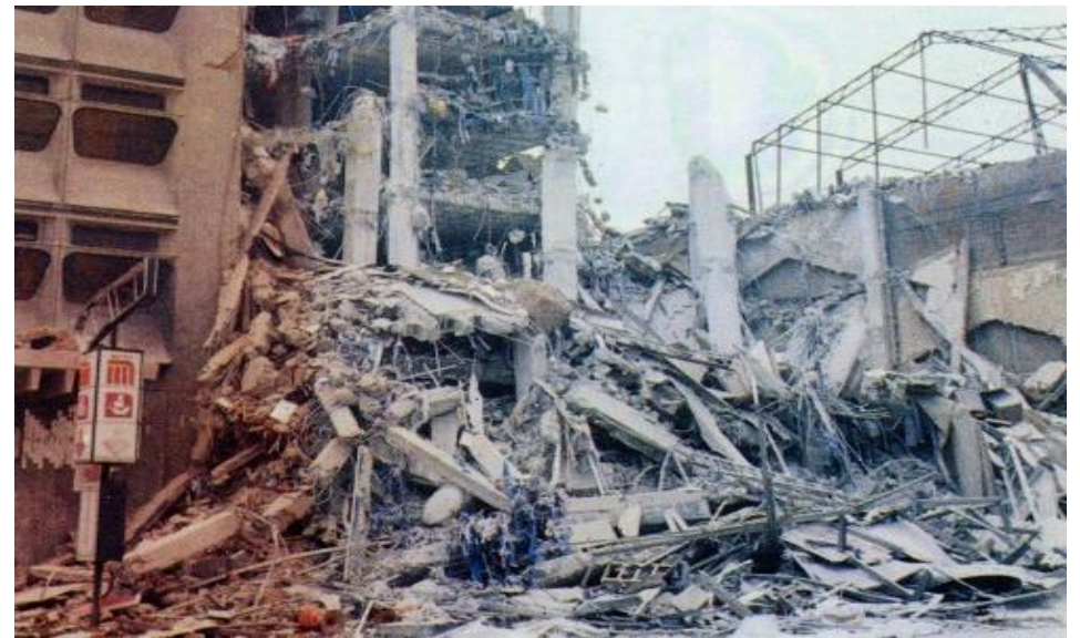
Figura I-5 Daños debidos al sismo de septiembre de 1985 en diversos edificios de la Ciudad de México construidos con losas planas.
